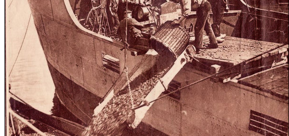
Voordat in 1931 de S.S.M. drijvende stoomgrijperkranen in gebruik nam werden de kolenscheppen gelost met scheppen en manden. De manden met kolen werden in het ruim en geschept en dan uit het ruim gehesen. Vervolgens op de bascule om te worden gewogen en dan werd de inhoud van de manden in naastliggende binnenschepen gestort.
